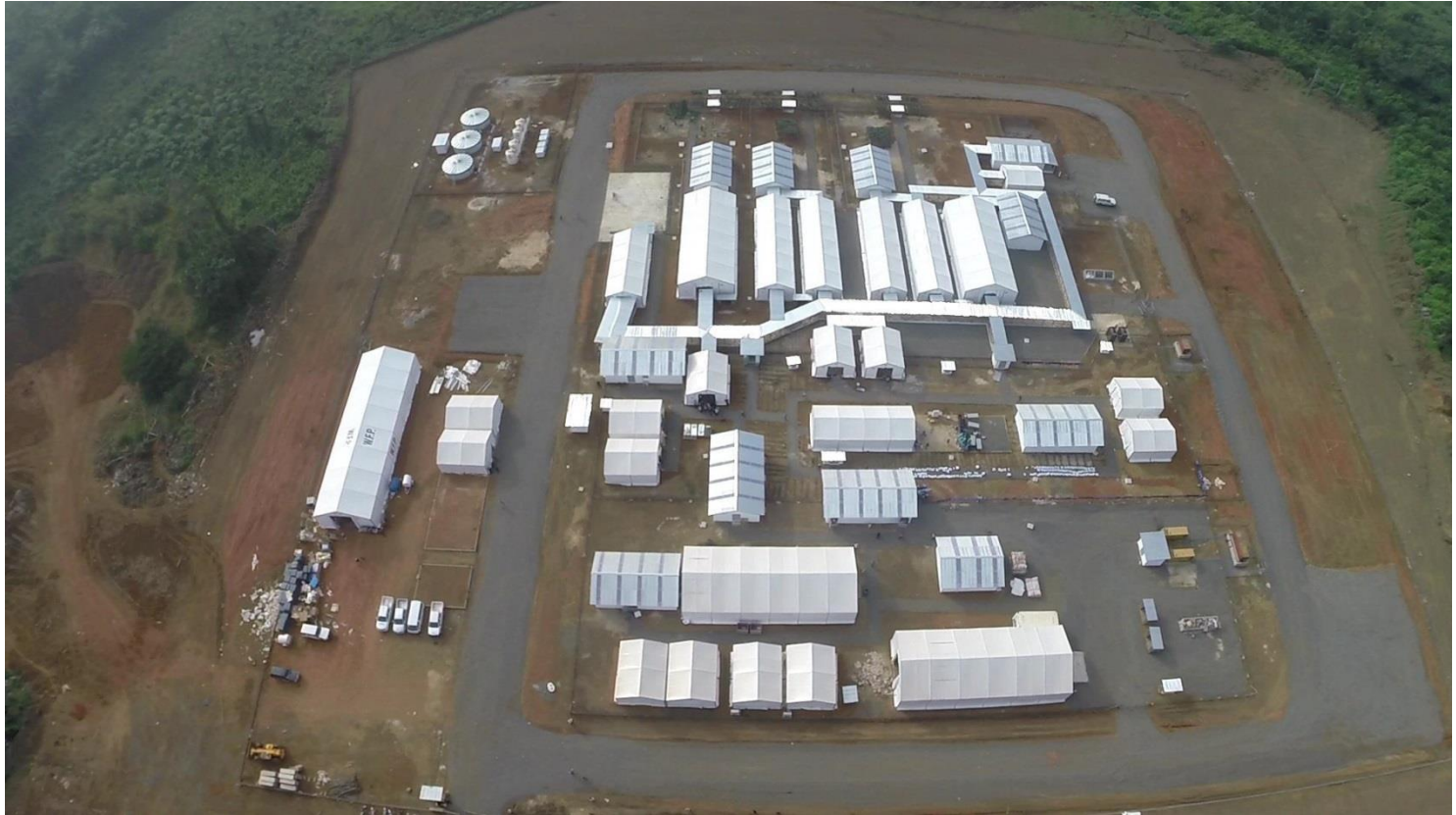
Centro de Tratamiento de Moyamba (en construcción)
